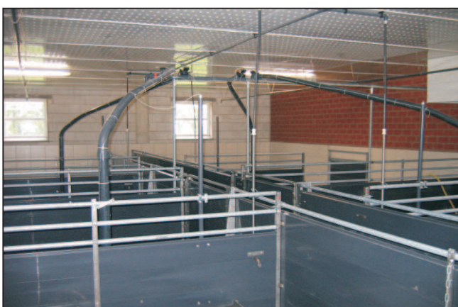
Quertrogaufstallung mit Sensorfütterung und variabler Buchtenabtrennung
