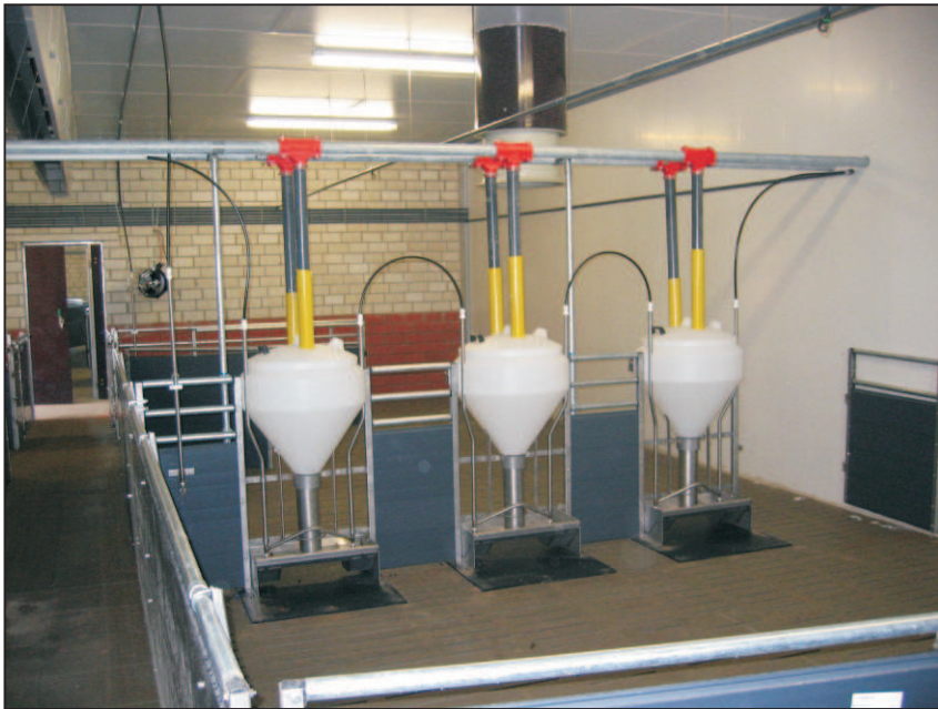
Rohrautomaten in der Trennwand
