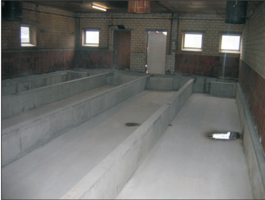
Flachkanal mit Aussparungen an der Stirnseite für Güleschieber
